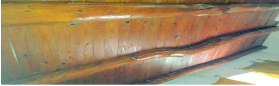
Deckenbalken im Gräserhaus
