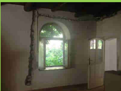
Fenster und Tür im Gräserhaus
