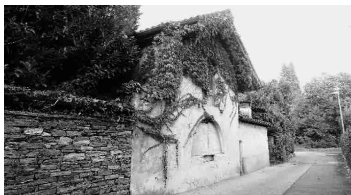
Das historische Gräserhaus am Monte Verità in herbstlichem Blätterkleid, Vorderfassade, Ascona, Oktober 2025
