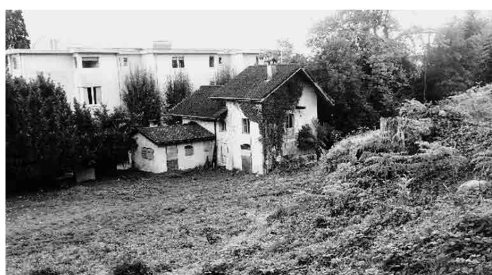
Blick auf die dem Berg zugewandte Nordfassade des historischen Gräserhauses – ein trutziges Relikt aus dem vergangenen Jahrhundert, umgeben von seinem verwilderten Garten im Herzen des Villenviertels, am Fusse des Monte Verità
